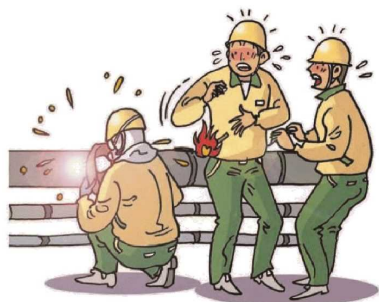
他者の近くでアーク溶接
