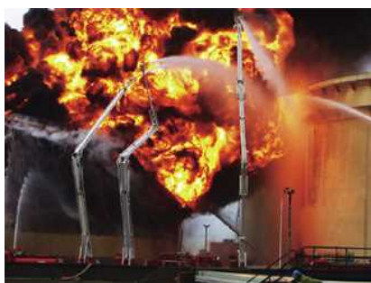
平成15年北海道苫小牧市で発生した出光興産(株)北海道製油所での原油貯蔵タンク火災 出典:平成26年版 消防白書
